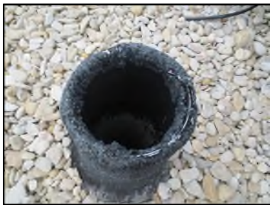
Photo N° 346 AMIANTE CIMENT -- TOITURE TERRASSE Toiture Ventilation haute (Fibres-ciment)
